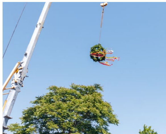
Der Richtkranz, Zeichen der Rohbaufertigstellung.
