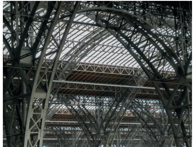
historische Stahlkonstruktion im Hauptbahnhof Leipzig (Bild: SLV Halle)
