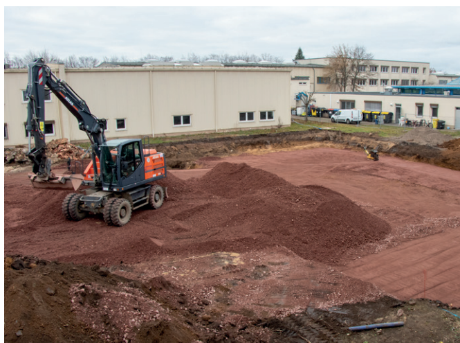
Einbau des Gründungspolsters (Bild: SLV Halle)
