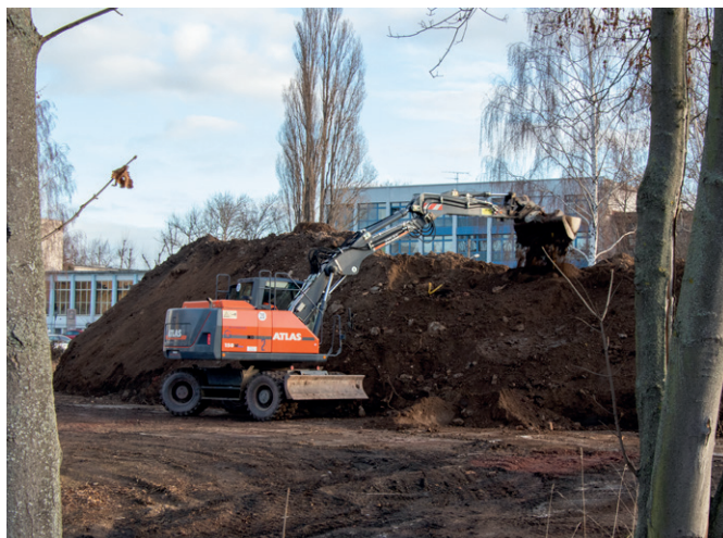
Fläche für Zwischenlagerung der Aushubmassen (Bild: SLV Halle)
