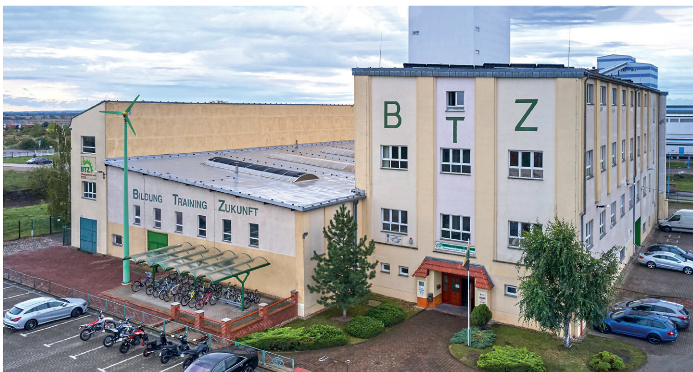
SLV Halle Betriebsstätte - BTZ Bernburg (Bild: SLV Halle)
